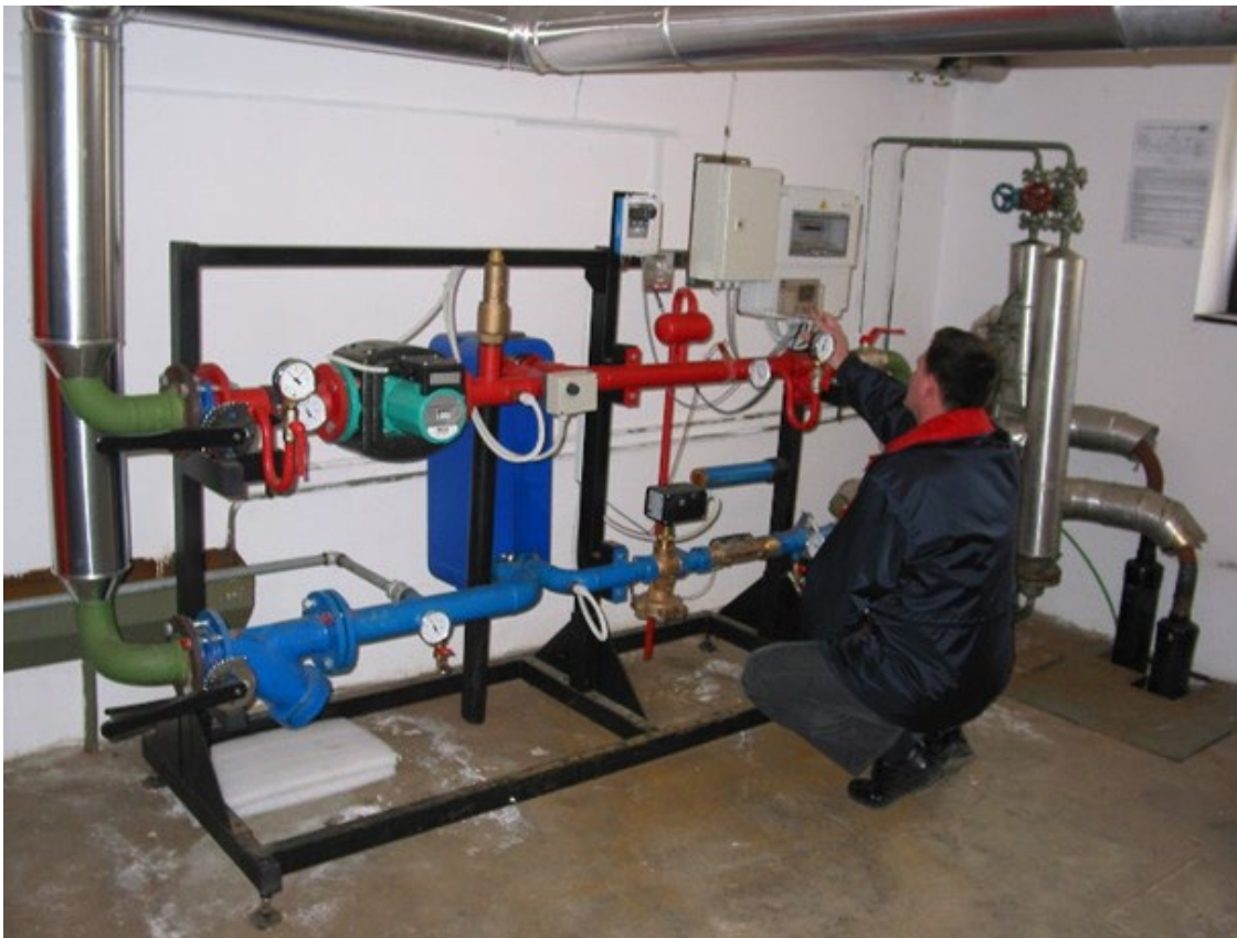
Slika 5: Kontrola delovanja indirektna toplotne postaje
