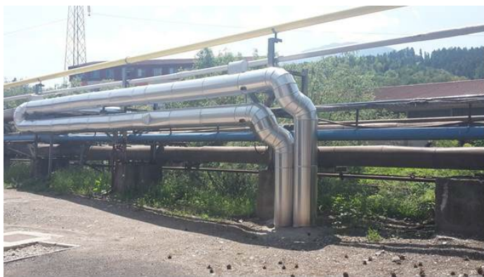
Slika 2: UHP peč, distribucijski vodi in postroji za koristno izrabo odvečne toplote
