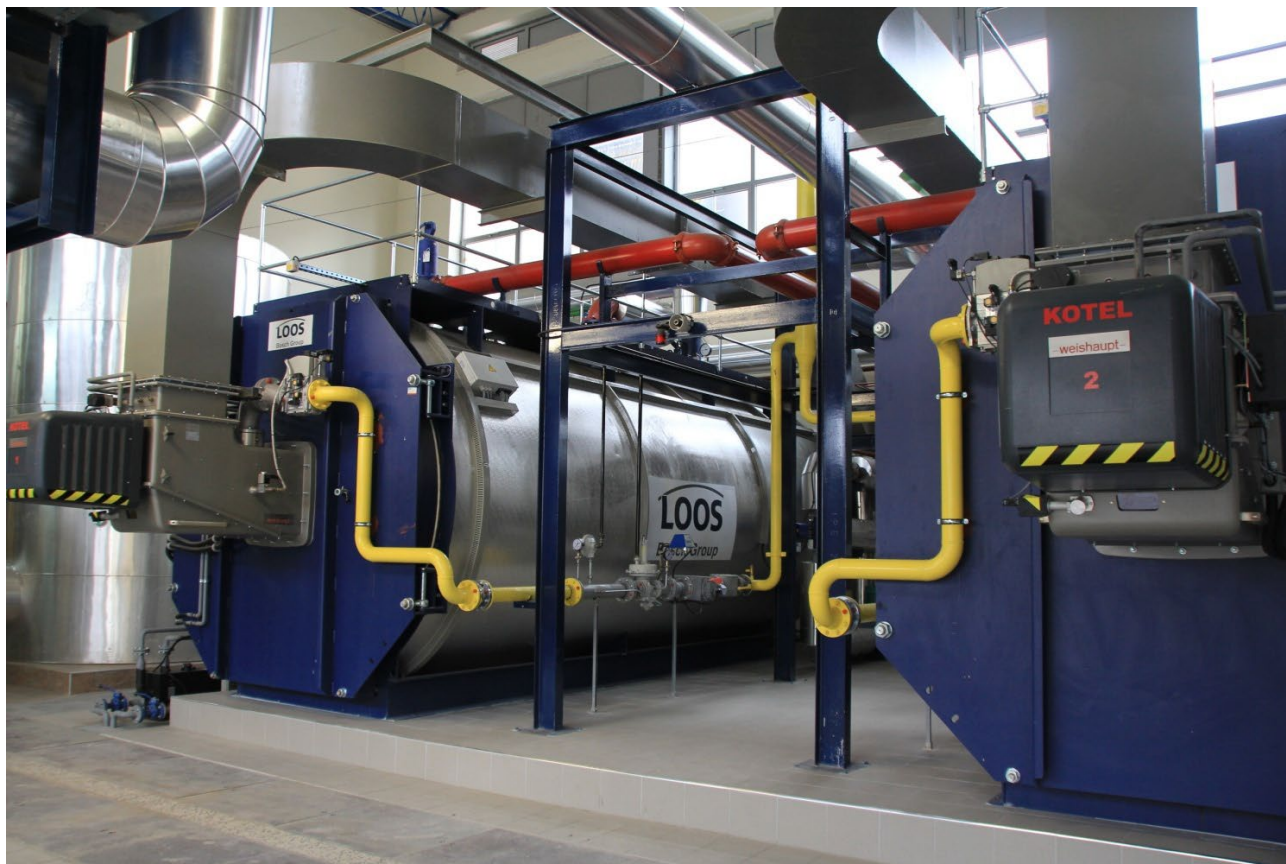
Slika 3: Proizvodnja vršne toplote na dveh vročevodnih kotlih LOOS INTERNATIONAL
